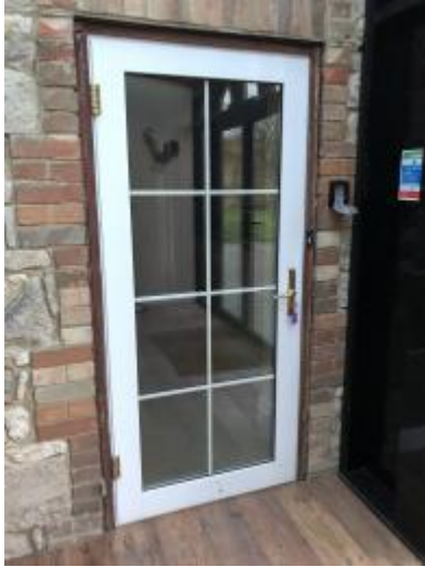
Inside front door
